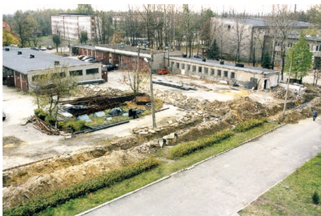
Teren szkoły wymagał gruntownego i szybkiego remontu
