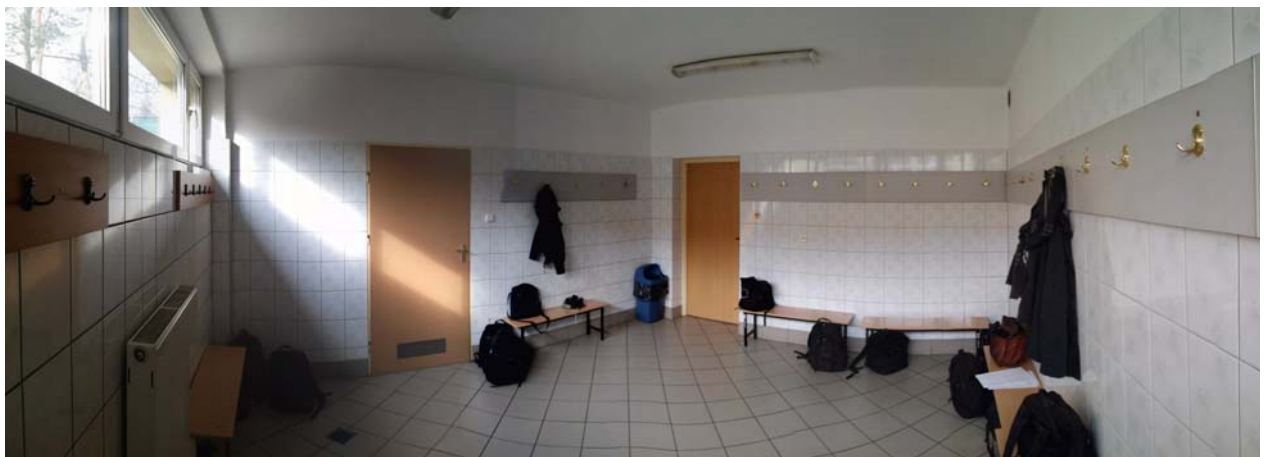
Foto.8 Pomieszczenie nr 4 - szatnia
