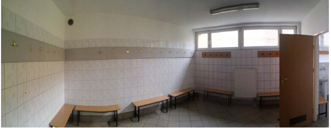
Foto.7 Pomieszczenie nr 4 – szatnia
