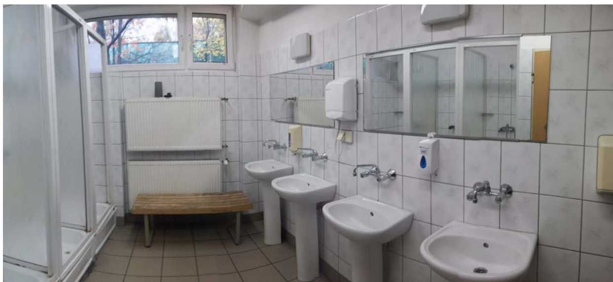
Foto.3 Pomieszczenie nr 2 - umywalnia
