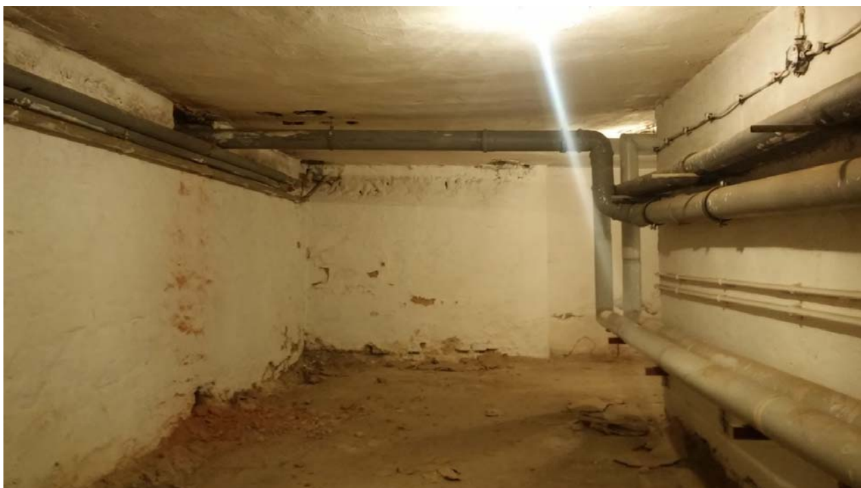
Foto.11 Podpiwniczenie - układ instalacji wod. -kan. i C.O
