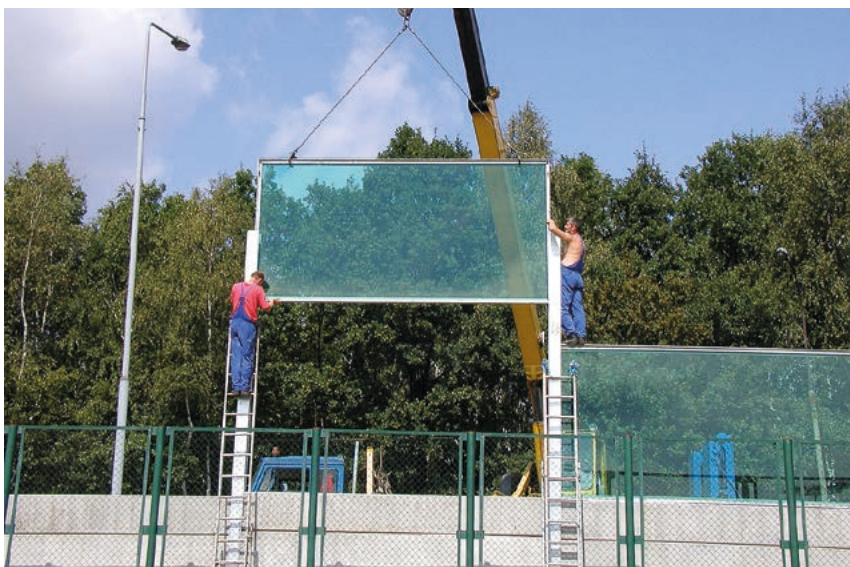
Sierpień 2007 r. – budowa ekranów dźwiękochłonnych wzdłuż ul. Kościuszki
