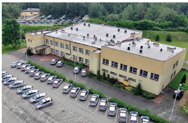
Stołówka (remont i modernizacja w latach 2002-2004)
