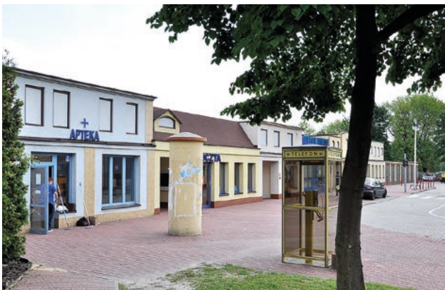
Wielofunkcyjne Centrum Symulacji (budowa 2006-2007)
