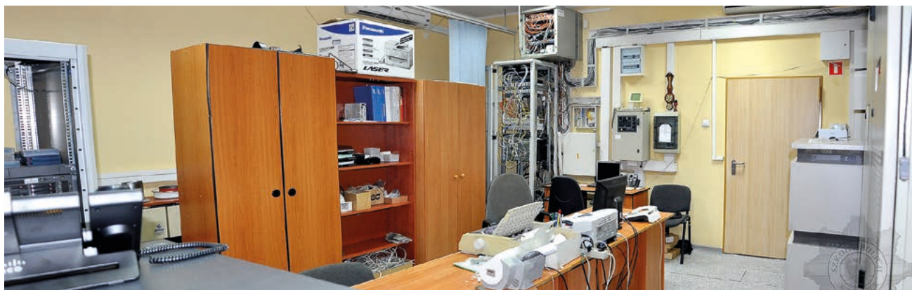
Pomieszczenie serwerowni przed modernizacją
