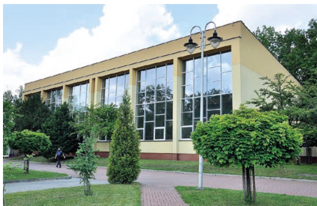
Hala sportowa (remont w 2003 r.)
