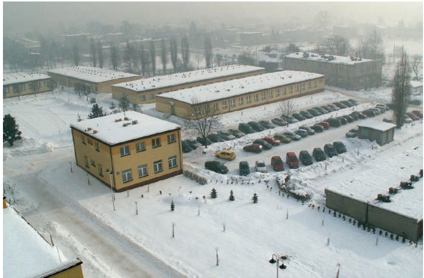
Styczeń 2006 r. – obiekty szkoły, z prawej strony garaże, na ich miejscu powstanie centrum symulacji
