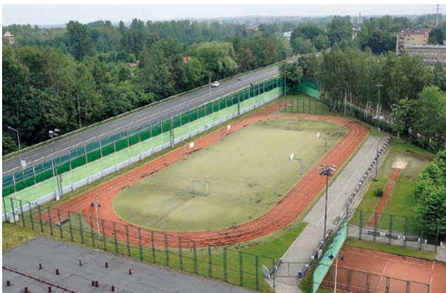
Zespół obiektów sportowych (budowa w 2005 r.)
