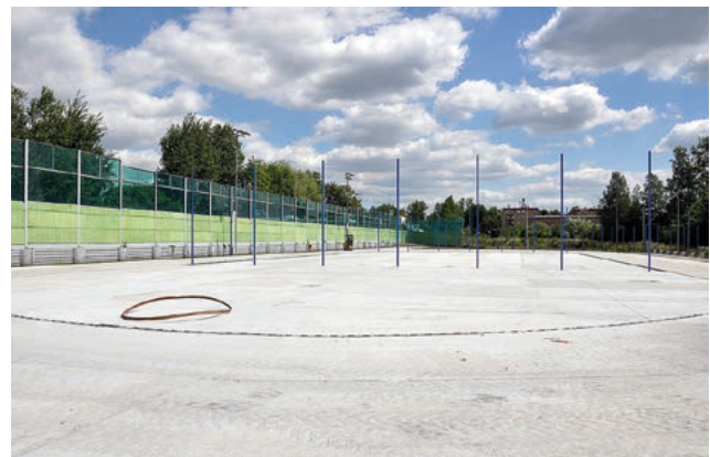
Zespół obiektów sportowych (w trakcie przebudowy w 2019 r.)
