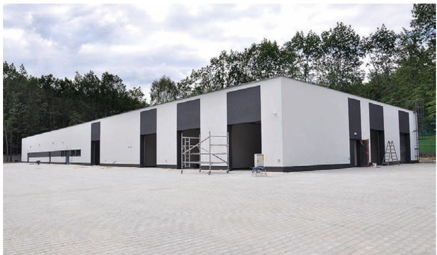
Budowa budynku magazynowego (2018-2019, w realizacji)
