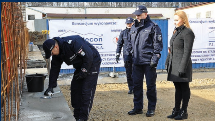
Wmurowanie aktu erekcyjnego pod przebudowę strzelnicy, luty 2020 r.
