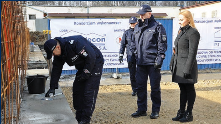
Wmurowanie aktu erekcyjnego pod przebudowę strzelnicy, luty 2020 r.
